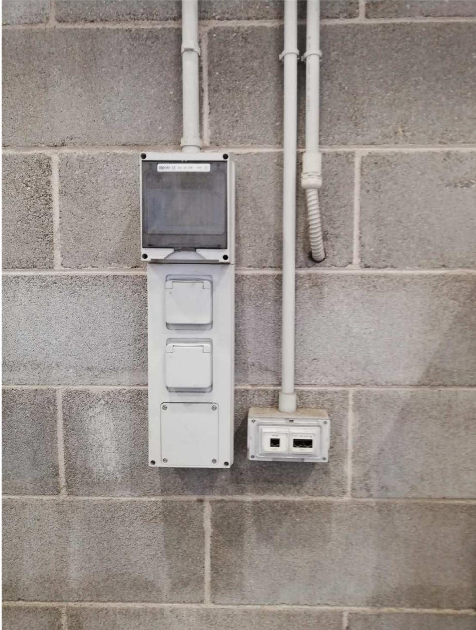
**Figura 6:** Posizionamento a muro della presa corrente “pulita” 220 V e della rete LAN
