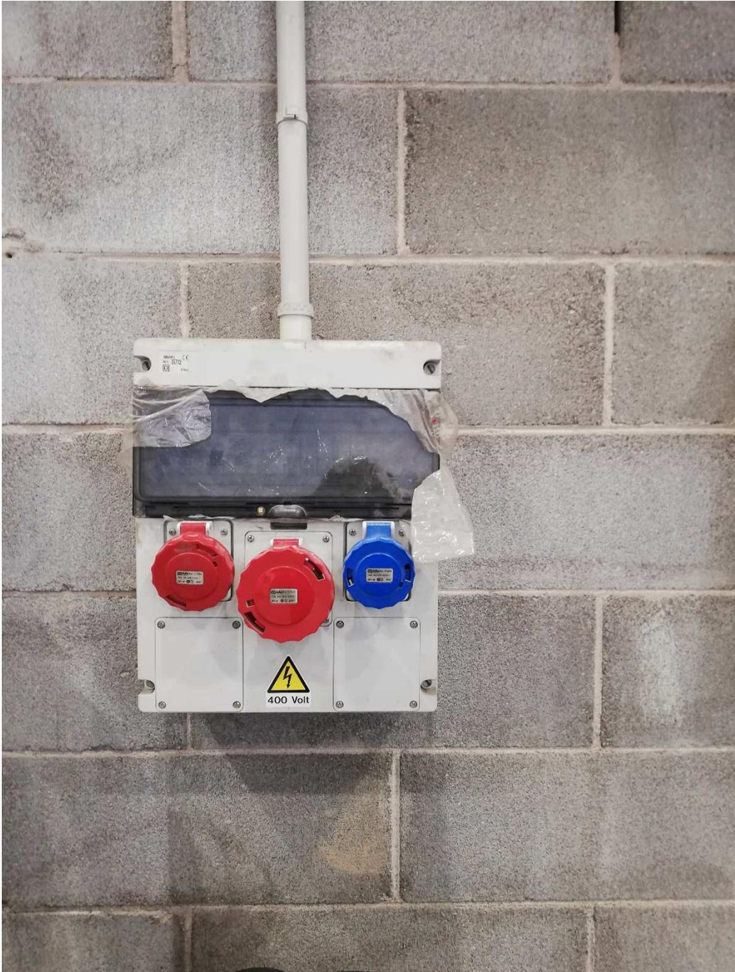
**Figura 5:** Posizionamento a muro della presa corrente 380 V trifase+neutro (grande e piccola) e 220 V LAN
