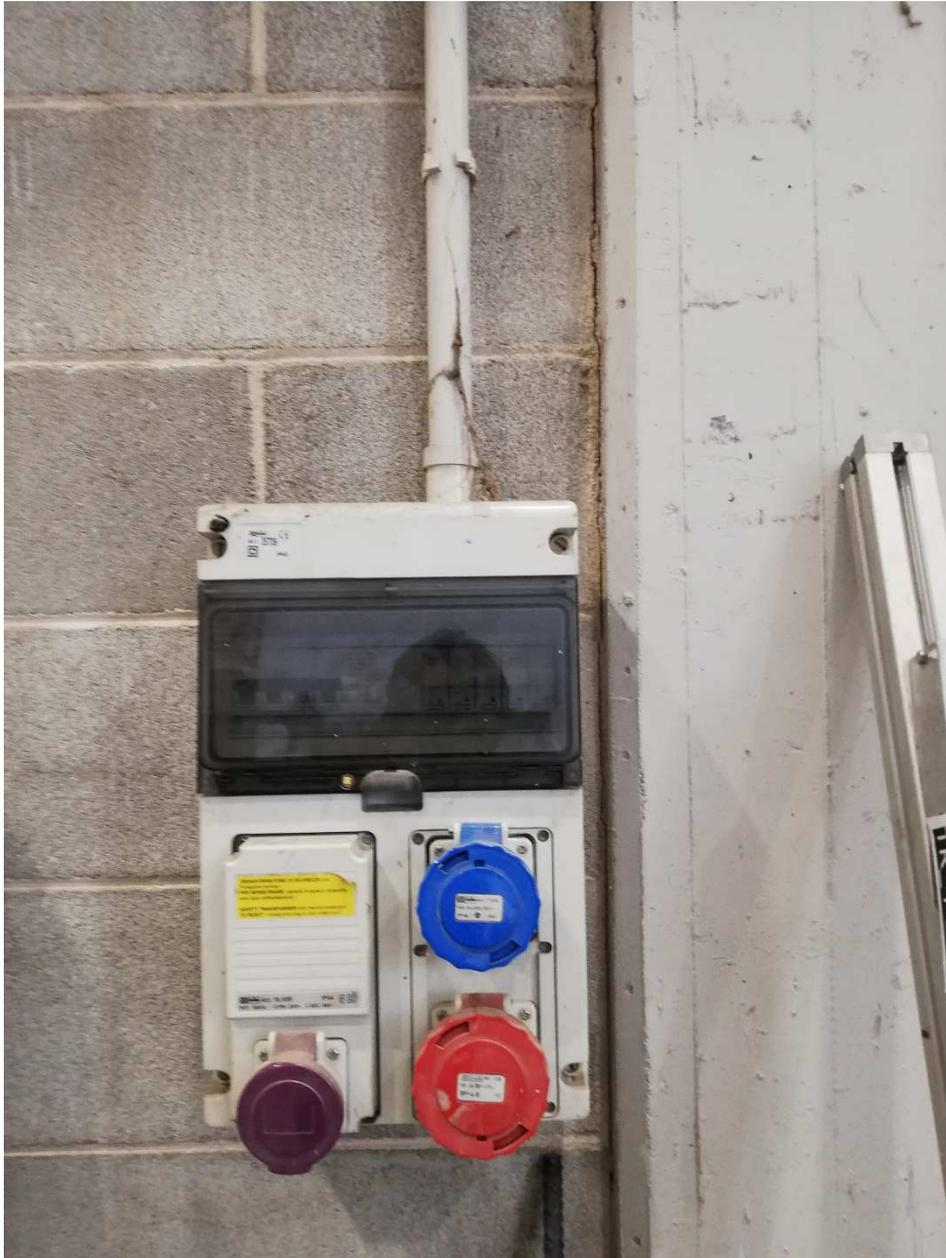
**Figura 7:** Posizionamento a muro della presa corrente 380 V trifase+neutro (grande) e 220 V
