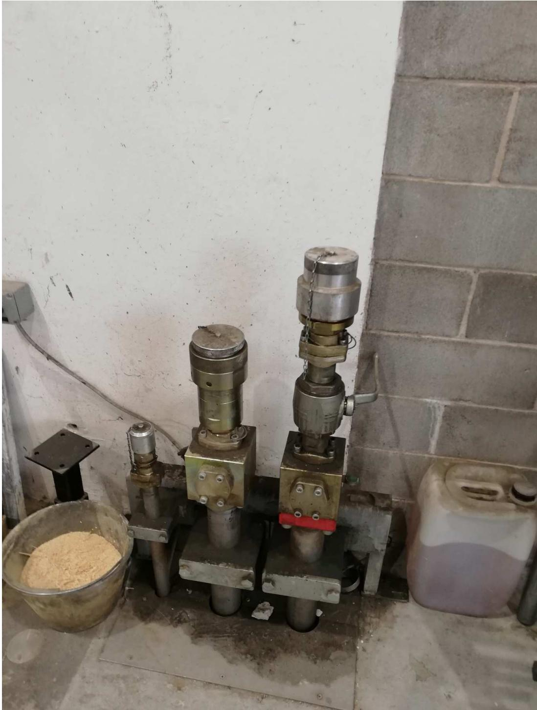
**Figura 3:** Posizionamento dello stacco dell'impianto oleodinamico costituito da tubi da 3" per mandata (Sch. 80) e ritorno (Sch. 40S) e 1 1/4" per il drenaggio (Sch. 40S).
